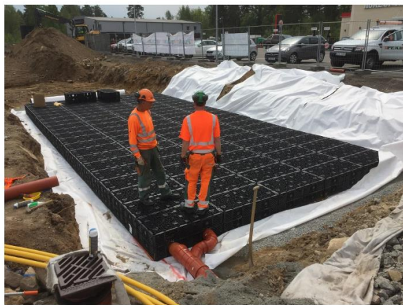
Figur 1. Sättning dagvattenmagasinskassetter, 2016-05-20
